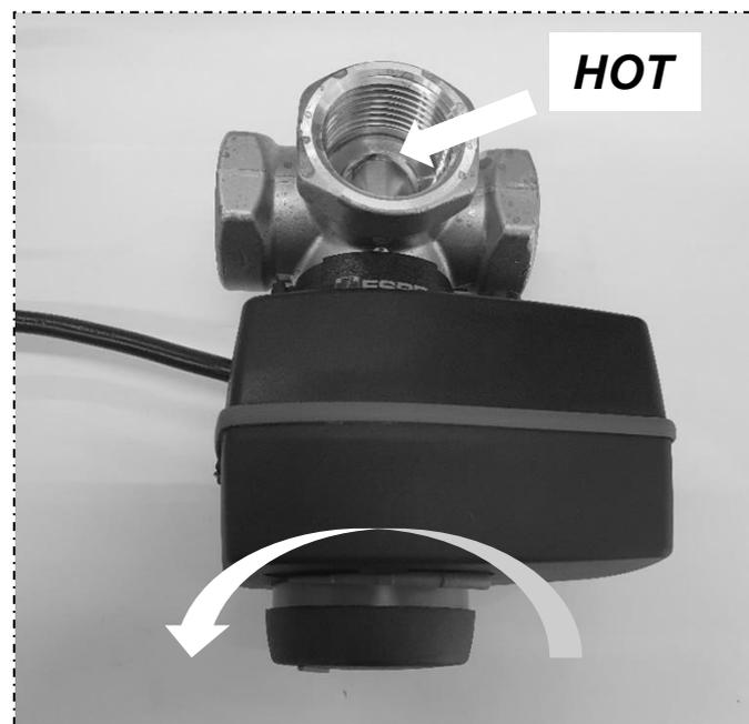
**7** - Pour vérifier si l'installation a été réalisée correctement, tournez le bouchon retiré dans le sens inverse des aiguilles d'une montre jusqu'à la fin de la course. Si la branche HOT est complètement fermée, l'installation a été complétée correctement, sinon il est recommandé de recommencer la procédure depuis le début.
